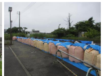
国道6号沿いに敷設された土嚢(牛久沼の越水防御対策、庄兵衛新田町付近)
