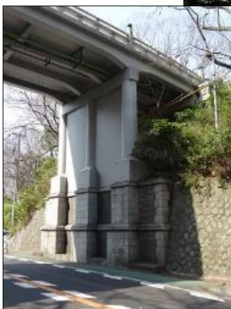
大手橋の下部
